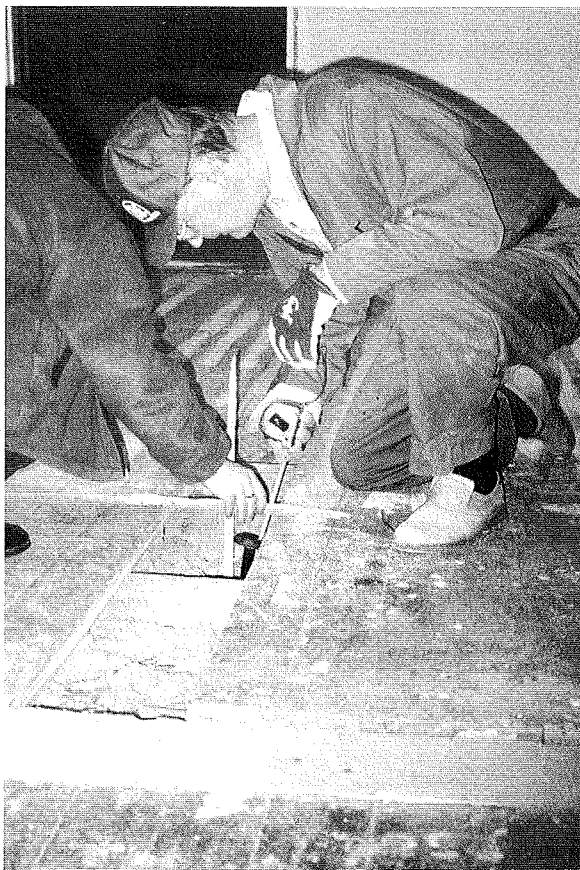
Taisto Mäki arviomassa mitä asbestilevyjen alta löytyy. Vanhan lattian täydellinen uusiminen on edessä. Eristeenä oli käytetty hiekkaa ja sammalta. Sen käytön syynä oli joko eristeen halpa hinta ja saatavuus tai siksi koska hiiren eivät viihdy hiekassa. Kumpi lie syynä vai molemmat?
