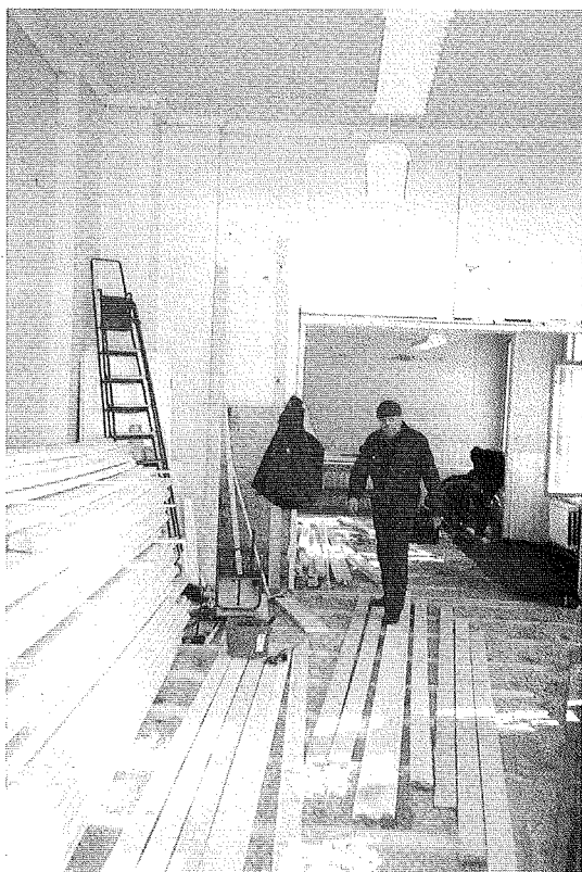
Lattia jouduttiin uusimaan täydellisesti. Lattialankua tilattiin 3000 jm. Vanhat lankut olivat niin kuluneet opinahjossa, että niitäkään ei voitu hyödyntää.
