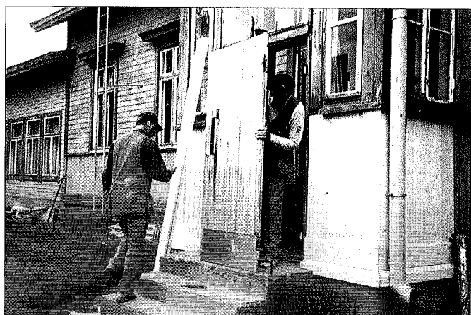
Kuvassa Taisto Mäki ja Markku Laaksonen. Vanhat Ulko-ovet poistettiin paikalta ja uudet laitettiin tilalle. Sisäovien pinnat entisöitiin museoviraston ohjeiden mukaan. Sisäovet ovat ilmeisesti alkuperäiset.
