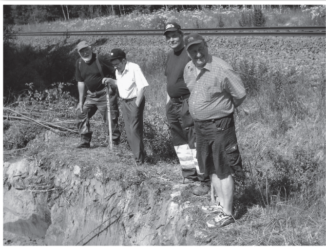
Jätevesiviemärin kaivuutöiden "tarkastus"
