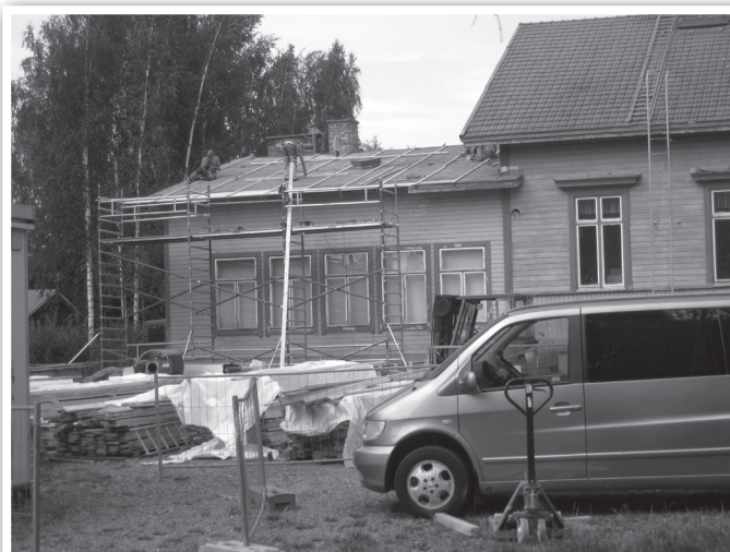
Kylätalon katto remontti kesällä 2010
