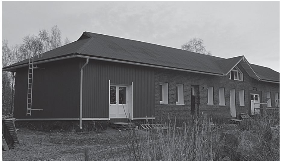
Yli 100-vuotias navetta/sikalarakennus Mörtintien varrella saa Jussin käsittelyn jälkeen uuden 100-vuoden jakson jatkaa hienoa rakennusperinnettä Kyläsaaressa.
