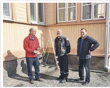
Pyörätuoliluiskan asennusta suunnittelemassa ovat Vesa-Matti Ketola, Vesa Virta ja Jarmo Jylli sekä kuvan ottaja Jarmo Huhtasalo.
